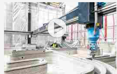
Casa stampata in 3D in Germania grazie alla ricerca nei materiali di Italcementi
